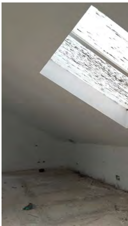
ESTADO ACTUAL DUN DOS LUCERNARIOS
