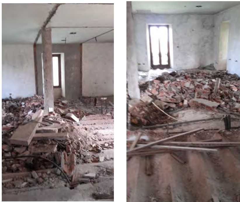
ESTADO ACTUAL DO INTERIOR DA PLANTA A ACONDICIONAR, A PLANTA ALTA DO PAZO.
